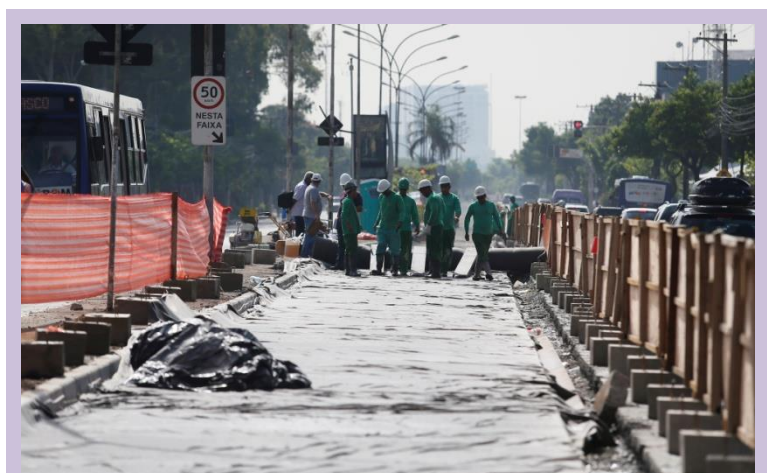
Corredor Inajar de Souza em obra
