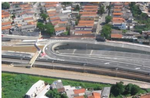
Passagem Subterrânea - Mar/06
