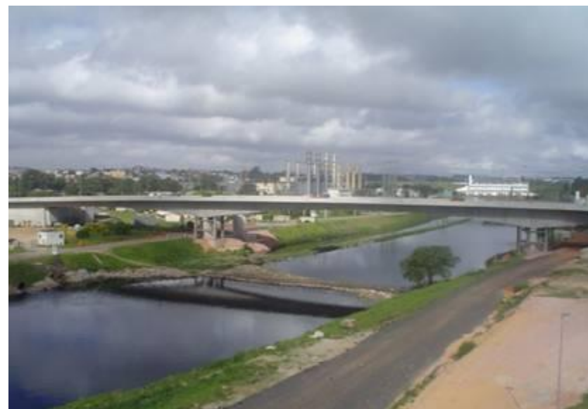
Primeira ponte – Out/06
