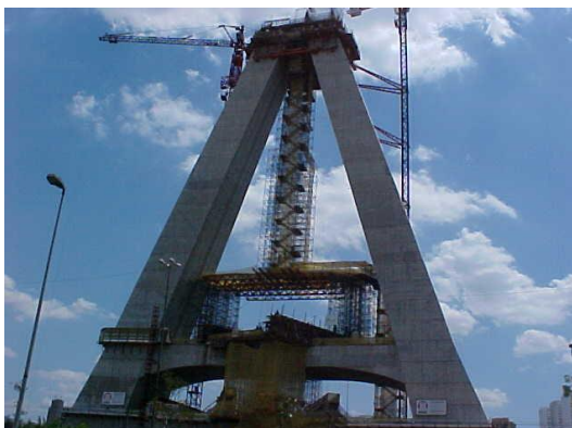
Execução do mastro – Fev/07
